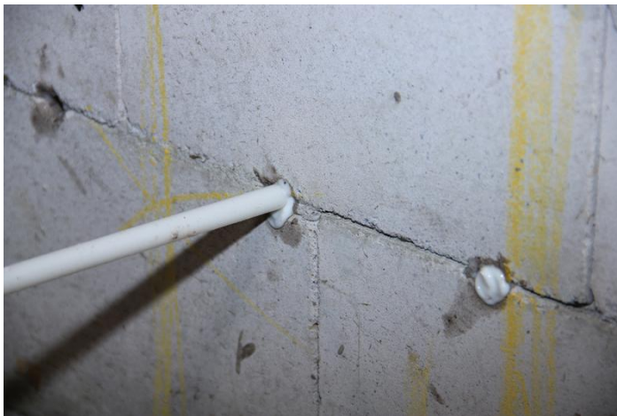
Das Bohrloch wird komplett mit der cremigen CO 82 Silaninjektion gefüllt. (Foto: Ceresit Bautechnik)
