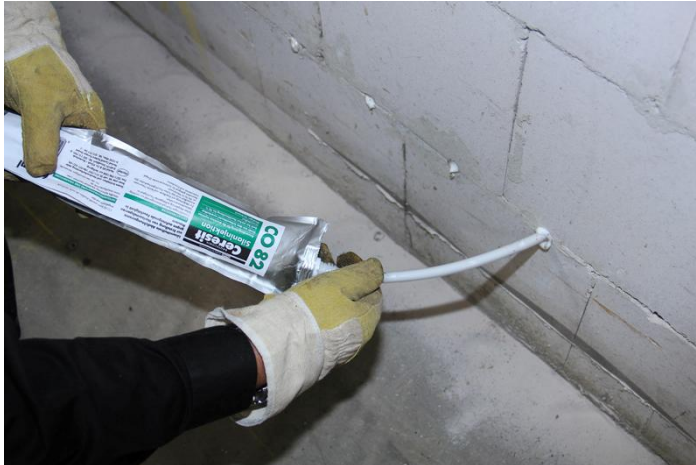
Aus einem 600ml-Schlauchbeutel mit beigefügtem Schlauch wird die Abdichtungslösung in das Mauerwerk eingebracht. (Foto: Ceresit Bautechnik)
