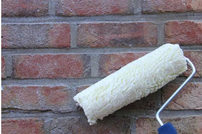
Die CT 8 Imprägniercreme schützt Fassaden gegen Schlagregen und verhindert Ausblühungen, und Frostschäden sowie Schimmel- und Moosbildung. (Foto: Ceresit Bautechnik)
