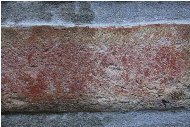
Imprägnierte Flächen sind zunächst gut erkennbar. Nach der Trocknung ist die CT 8 Imprägniercreme nicht mehr sichtbar. (Foto: Ceresit Bautechnik)
