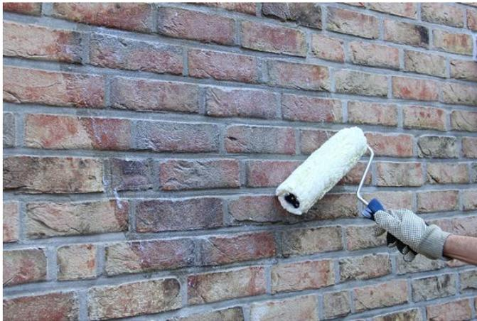
Mit der Rolle lässt sich die CT 8 Imprägniercreme gleichmäßig und zugleich sparsam auftragen. Der Wirkstoff dringt tief ein und ist dauerhaft wasserabweisend. (Foto: Ceresit Bautechnik)
