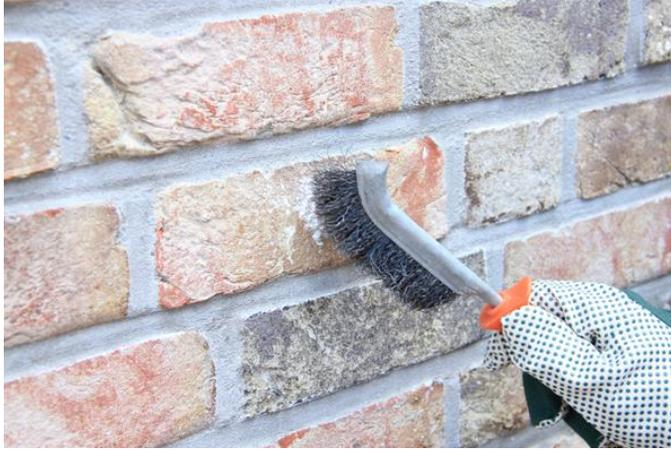
Die CT 8 Imprägniercreme wird auf sauberen und trockenen Baustoffen eingesetzt. Bewitterte und stark verschmutzte Oberflächen sollten vorab gereinigt werden. (Foto: Ceresit Bautechnik)
